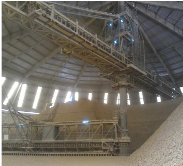
Figure: prehomogenisation avec deux navettes
