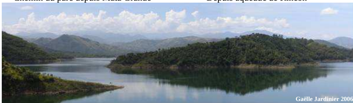
La retenue d'eau du barrage de Monción.
