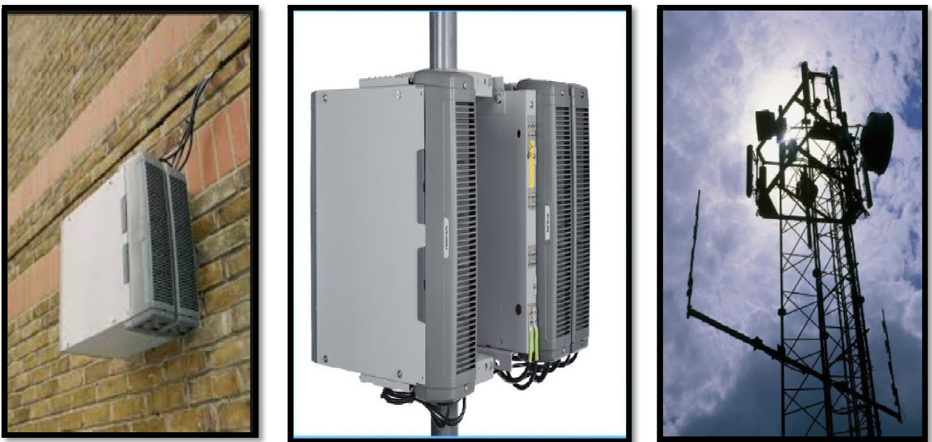
Figure 22 : Différents scénarios d'installer une BTS Flexi de Nokia
