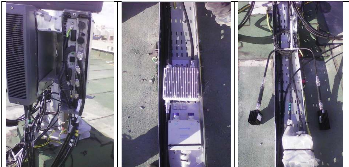
Figure 43 : Photo d'installation du réseau LTE avec le SM
