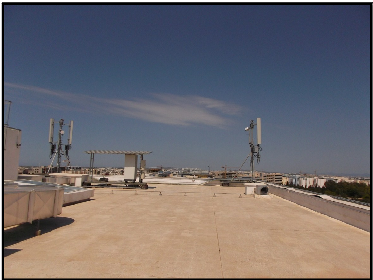
Figure 27 : Exemple d'installation d'une Solution Feederless de Nokia (FO entre les SM et les RFMs)
