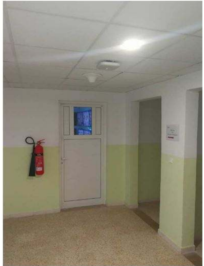
Figure 47 : Antennes cuisine et administration sous-sol
