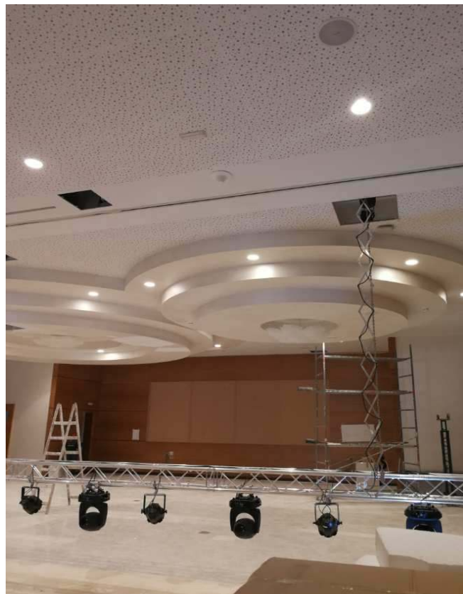
Figure 48 : Antenne salle de conférence
