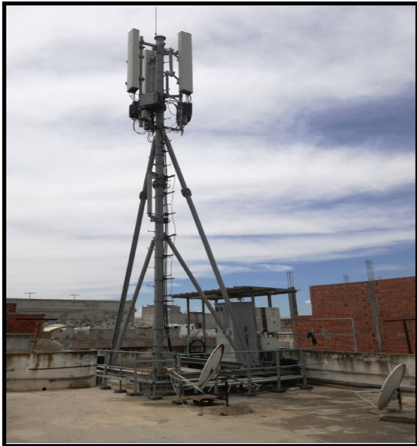
Figure 27 : Exemple d'installation d'une Solution Feederless de Nokia (FO entre les SM et les RFMs)
