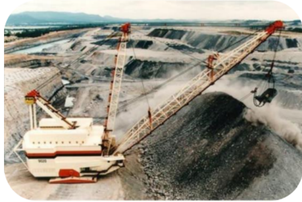
(b) décapage par dragline
