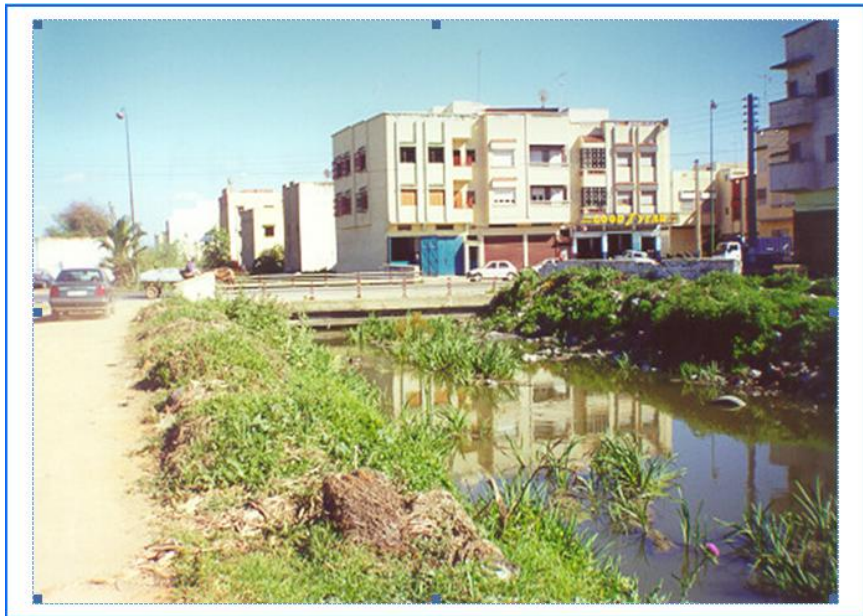
Photo 3: Oued Fouarat, vue prise du pont de la RN°1 (ABHS 2008)
