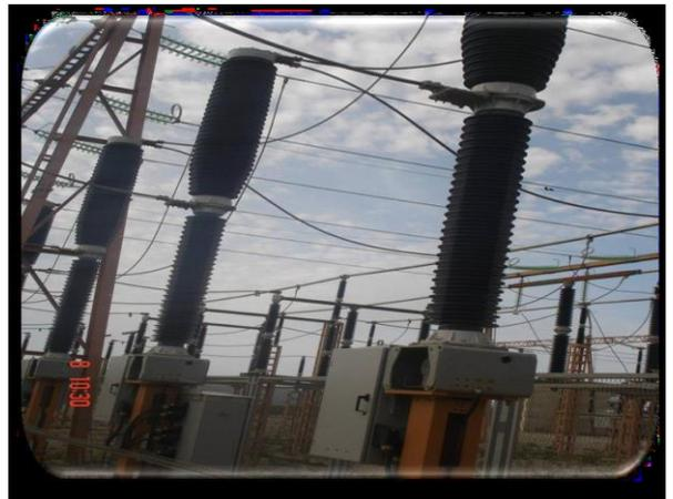
Figure 29 : disjoncteur de travée
