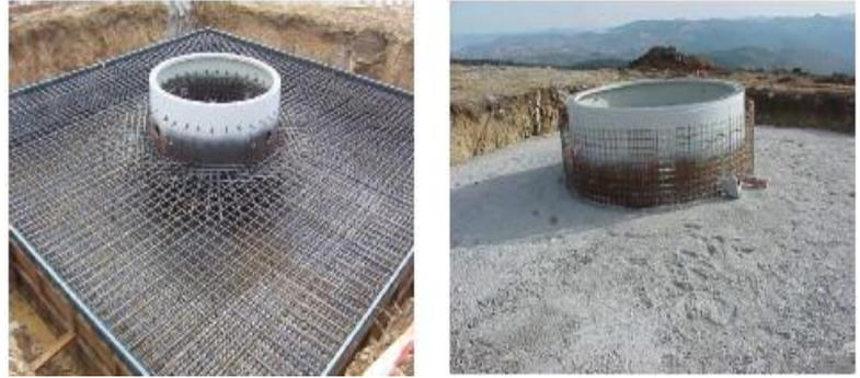
Figure 26 : Armature et Bétonnage de la fondation
