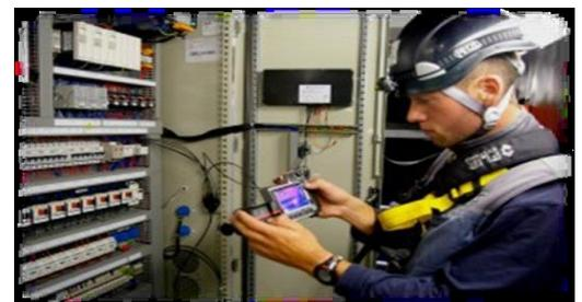
Figure 41 : Technicien réalise la maintenance préventive
