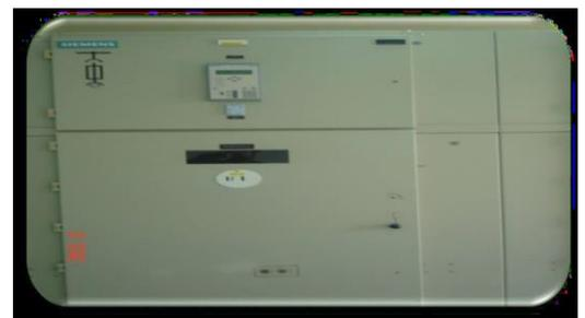
Figure 37 : Cellule de mesure
