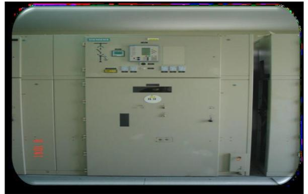
Figure 39 : Cellule de l'arrivée transfo 33/225KV
