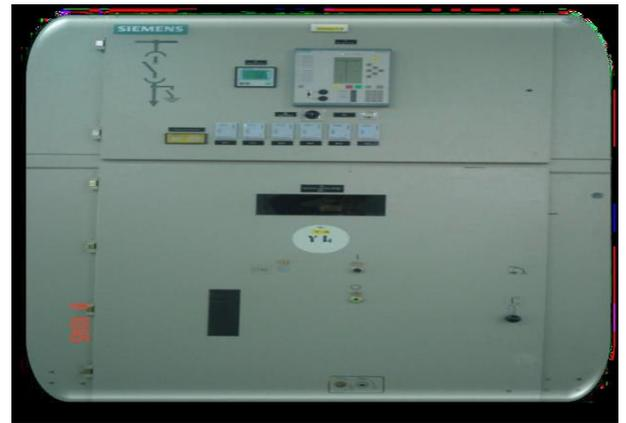
Figure 35 : Cellule du circuit d'arrivée
