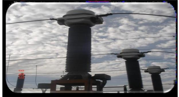
Figure 31 : transformateur du courant
