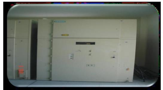
Figure 36 : Cellule de réactance
