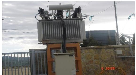
Figure 32 : transformateur des services auxiliaires
