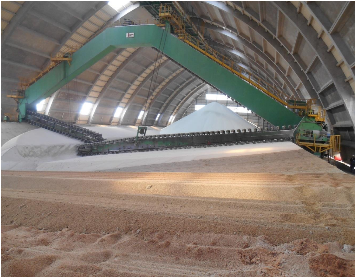
Figure II.1 : Vue sur le gratteur du hangar HE 2
