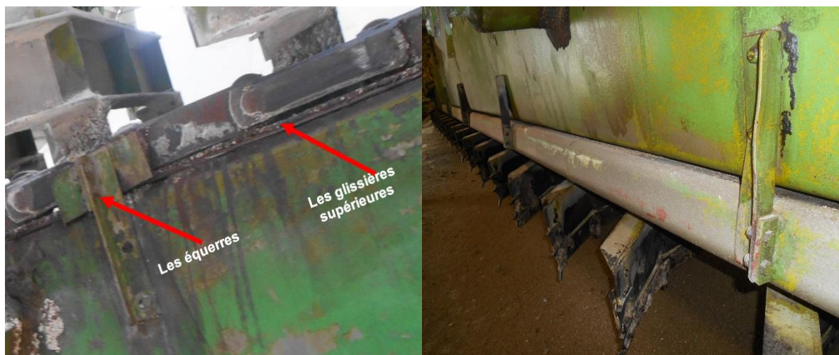
Figure III.3 : Vue sur les glissières
