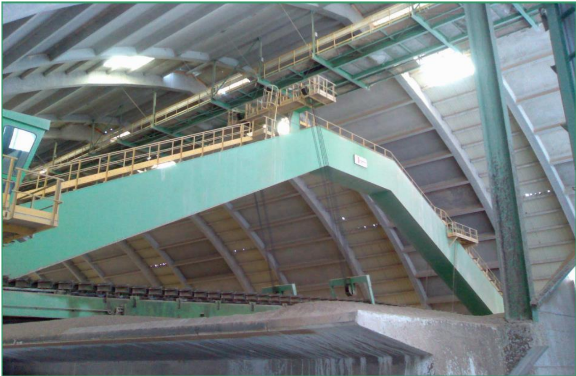
Figure II.3 : Vue sur le pont
