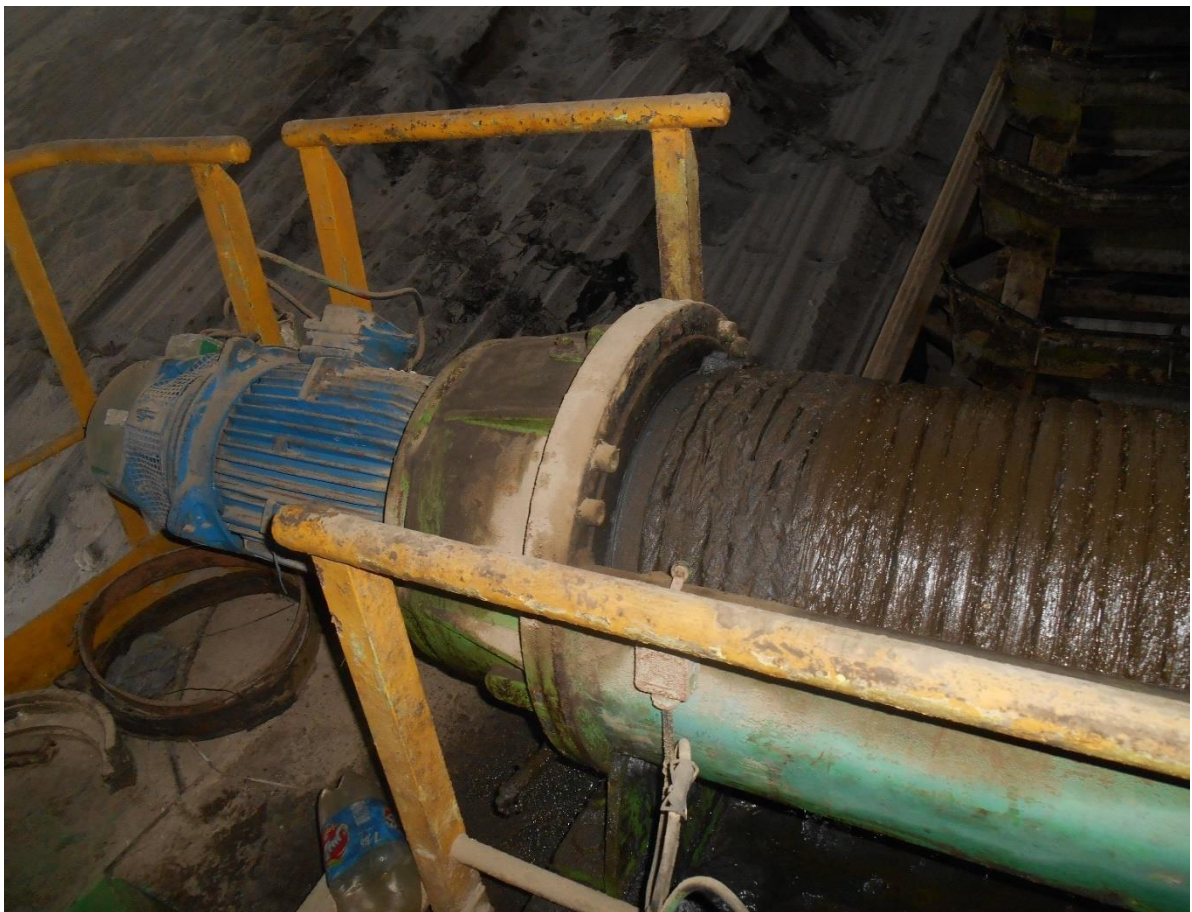
Figure II.8 : Vue sur le treuil de levage
