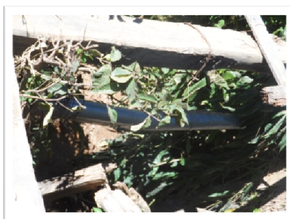
Figure 19: Tuyau à couverture métallique accroché sous le petit pont
