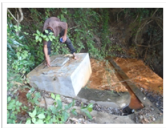
Figure 11: Vue extérieure du bassin de captage C_1
