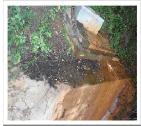
Figure 12: Aspect de l'eau contenue dans le bassin C 1 Figure 13: L'eau venant de la fuite du bassin.
