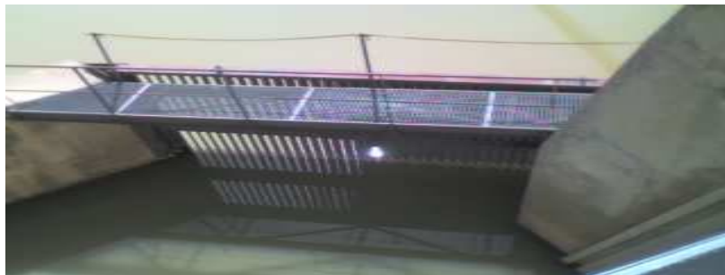
Photo 2 : prise d'eau contenant une grille.
