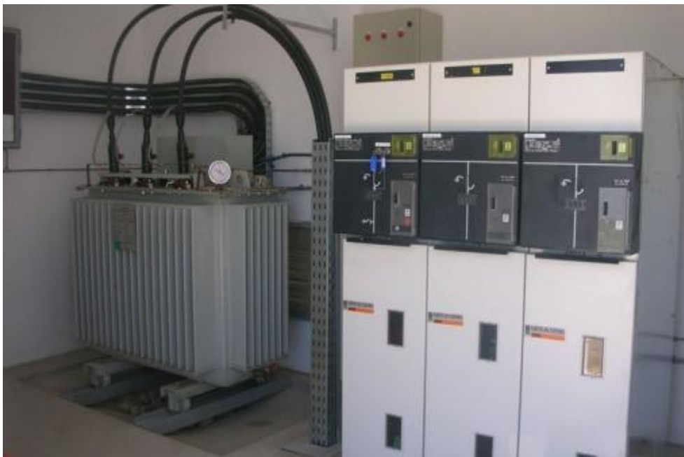
Figure 6 : Transformateur MT/BT.
