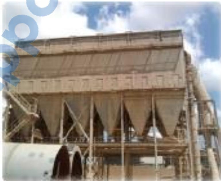
**Figure:7 Cellule de dépoussiérage**
