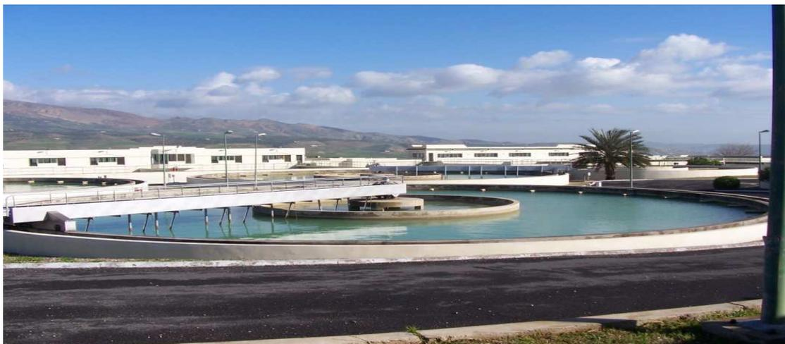
Figure 5 : Décanteurs à racleurs
