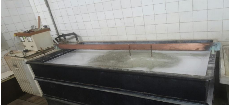
Photo 8 : bain du dégraissage
