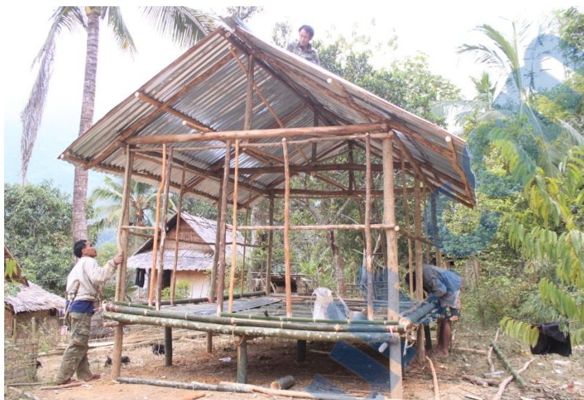
Figures 4.46-47 L'installation des liteaux
