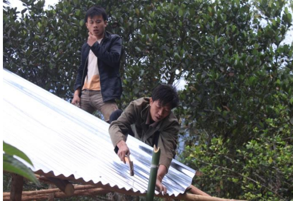
Figure 4.45 La pose des tôles. On voit, devant les tôles, le bambou qui a permis son maintien par le dessous
