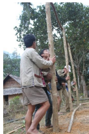
Figures 4.5 et 4. 6 Les deux rangées de trois poteaux sont redressées par les plus jeunes
