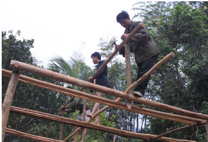
Figures 4.37 et 4.38 Fixation de la panne faîtière
