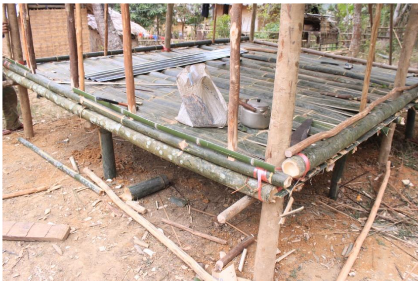
Figure 4.32 Le plancher terminé
