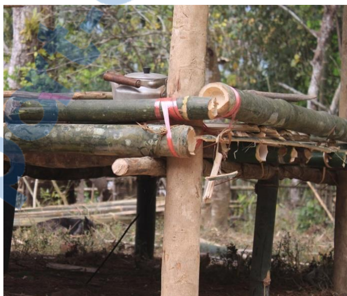
Figure 4.31 Les ficelles qui tiennent les différentes parties du plancher
