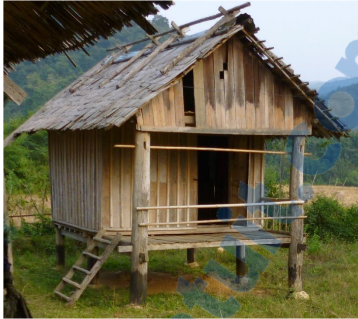
Fig. 4.16 Bungalow pour touriste en rénovation. On peut voir la même structure des six piliers en deux rangées parallèles
