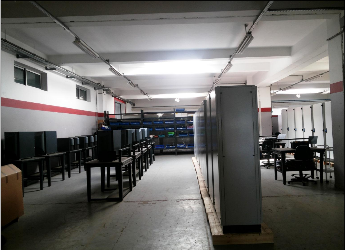
Figure 42 : Etat de l'atelier après l'implantation
