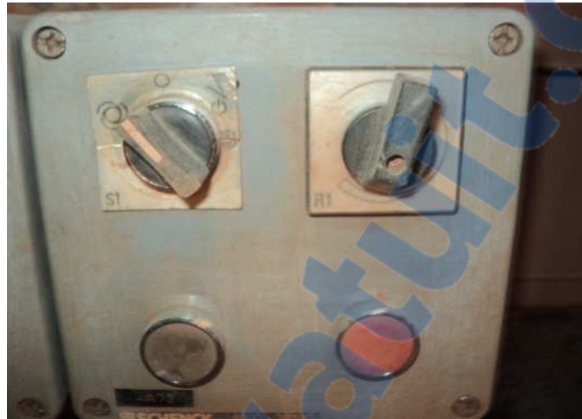
Figure 3-10 : Unité de commande locale VLG
