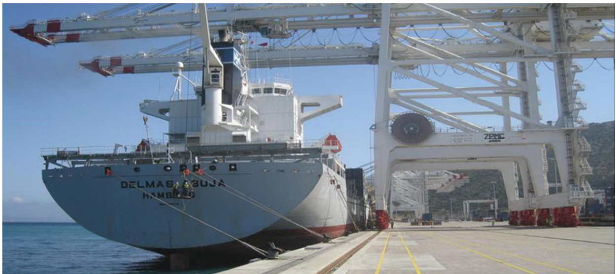
Figure 6 : Grue de quai
