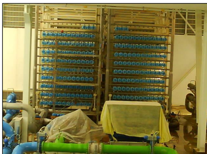
Figure 2-13 : Châssis à membrane
