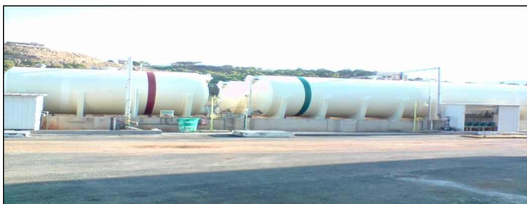
Figure 2-9 : Citernes de l'hypochlorite de sodium et chlorure ferrique
