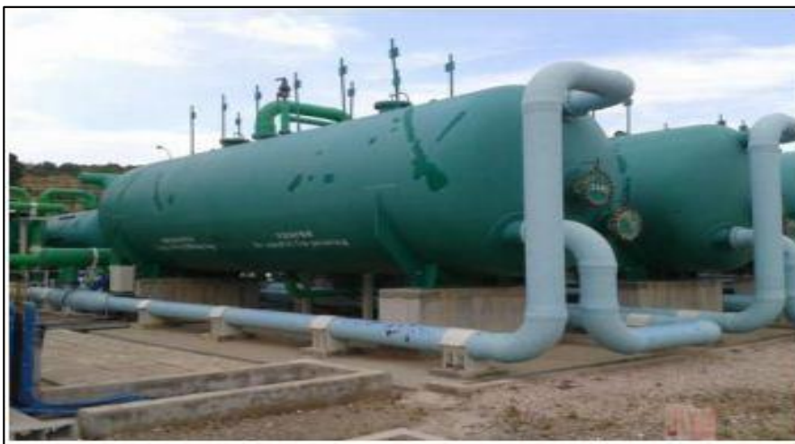
Figure 2-11 : Filtres à sable et anthracite
