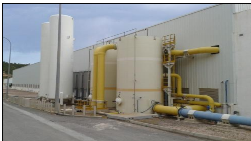
Figure 2-20 : Réservoir de CO_2
