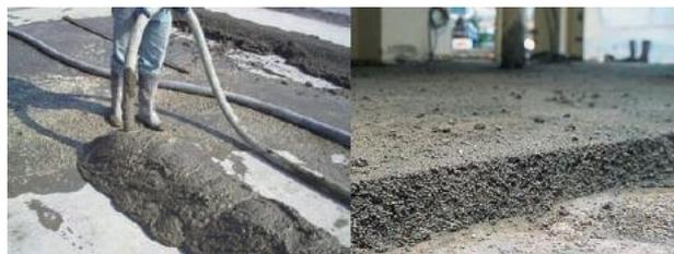
Figure II.17 : Béton de polystyrène (Source : REME, 2015)
