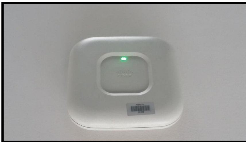
Figure 31 : La mise en place des points d'accès.
