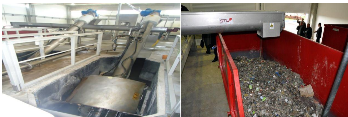
Figure 4: Degrilleur auto et refus de dégrillage
