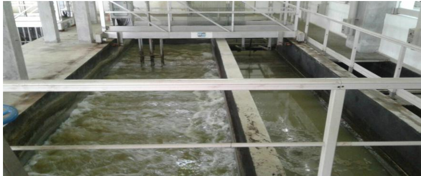
Figure 5: bassins de dessablage/déshuilage
