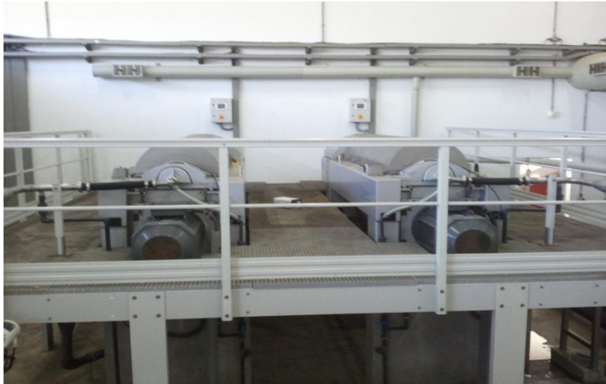
Figure 12: centrifugeuses pour déshydratation
