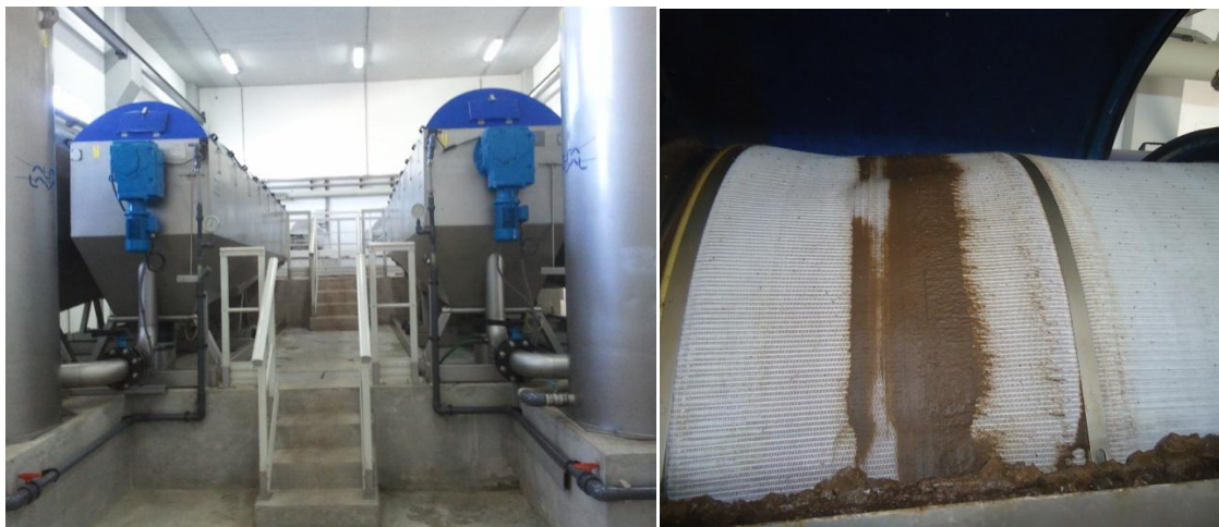
Figure 11: filtres rotatifs
