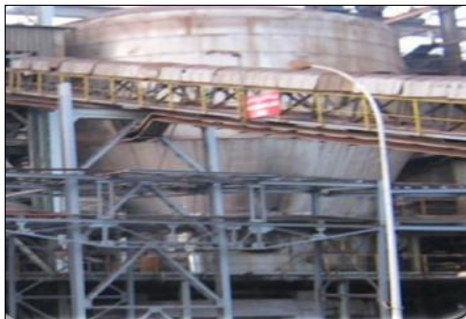
Figure1.3: Four (M26) dans le service « Grillage ».
