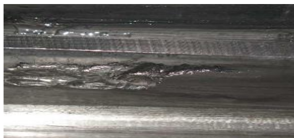
Figure 3.9 : Ecaillage par fatigue [31]
