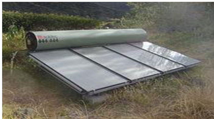
Figure II.3: Capteur solaire à eau
