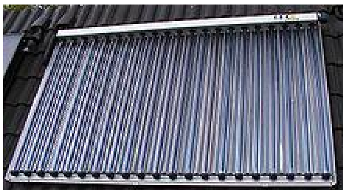
Figure II.6 : capteur à sous vide
