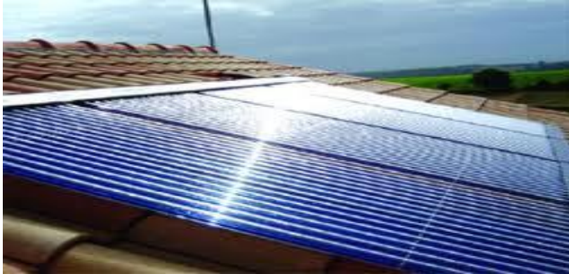
Figure II.2: Un panneau solaire thermique
