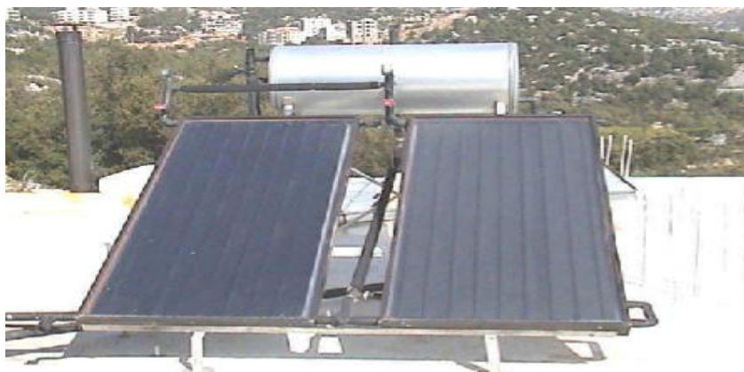
Figure II.5 : capteur plan vitré
