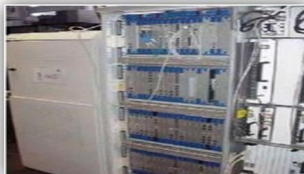
**Figure II. 7: Contrôleur de Réseau Radio (RNC)**
