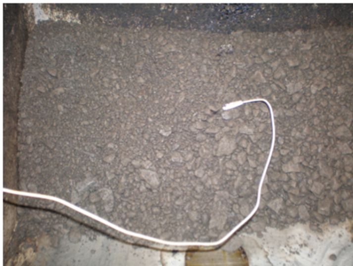
Figure 2.4 Aspect du MR-5 à la mousse de bitume
