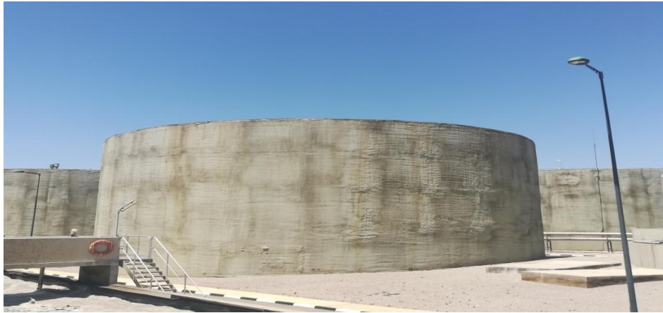
Figure 12 : Digesteur
