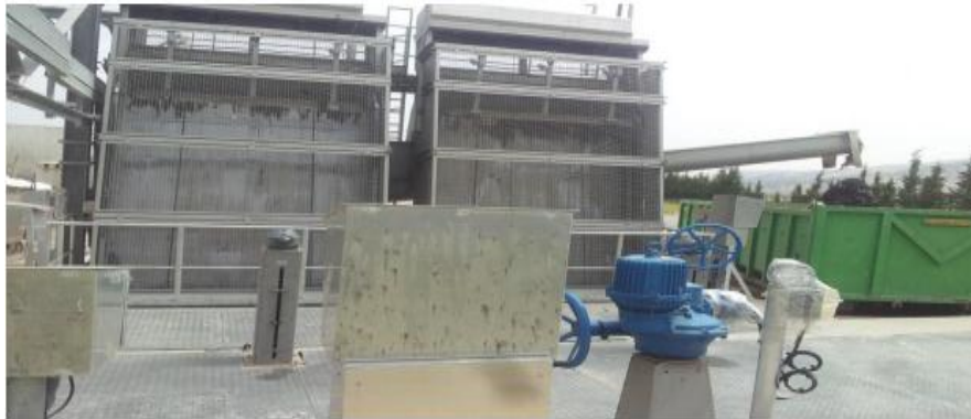
Figure 2 : Dégrilleur grossier
