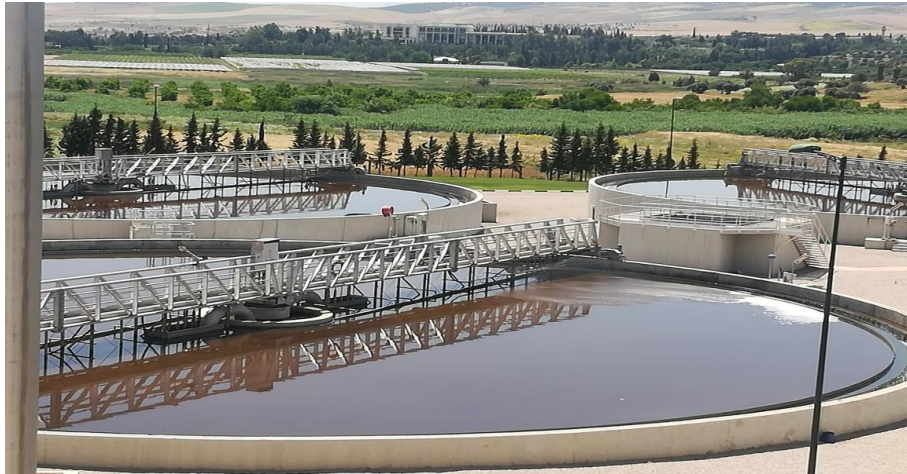
Figure 8 : Clarificateur
