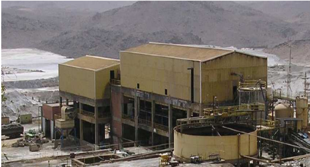
Photo 3: la mine de Bou Azzer dans la région de Ouarzazate.
