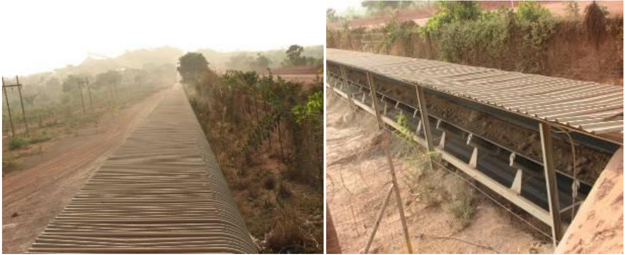
Photo 19 : site d'exploitation envahi et tapis de transport du minerai de la SAG.
