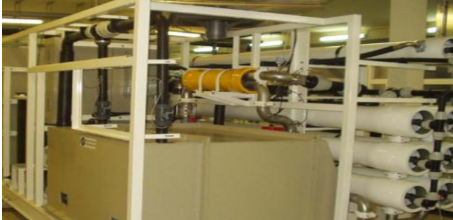
Figure III.8 : Echangeur type PX 180 sur l'une des unités SLCE de 500 m 3 /jour de l'installation d'Anaux sur l'île de Bora-Bora
