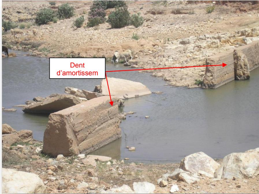
Photo 3.14 : dent d'amortissement du bassin emportée, absence de protection aval contre les affouillements (CTH, 2006)
