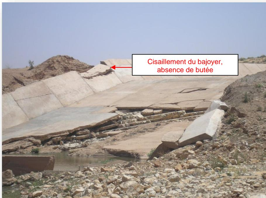
Photo 3.11 : Dégradations importantes sur le rapide, absence d'appuis du radier sur les sols de fondations (CTH, 2006)
