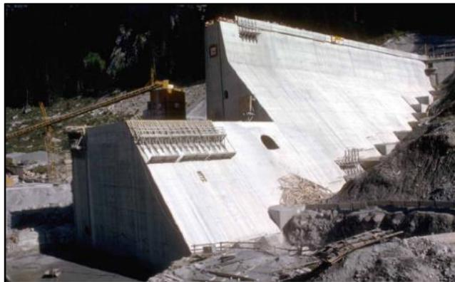
Photo 2.2 : Construction d'un barrage poids
