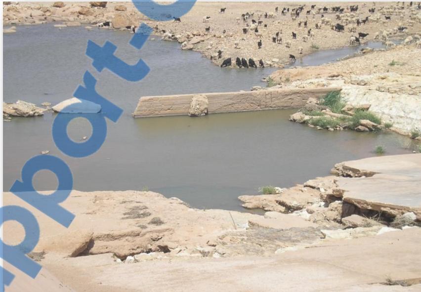
Photo 3.13 : Bassin de dissipation complètement détérioré, ressaut dénoyé et ouvrage emporté (CTH, 2006)
