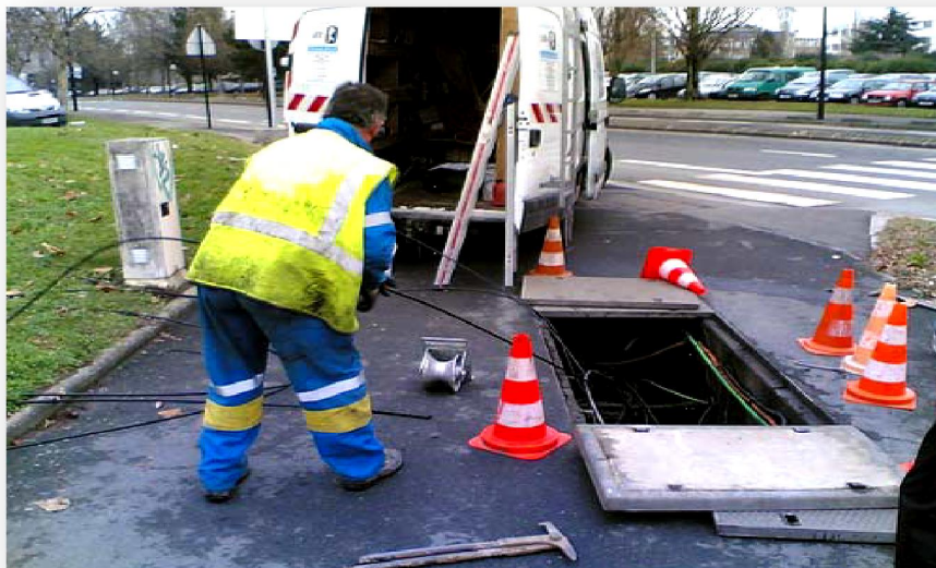
Figure III.8 : Méthode de tirage de fibre optique
