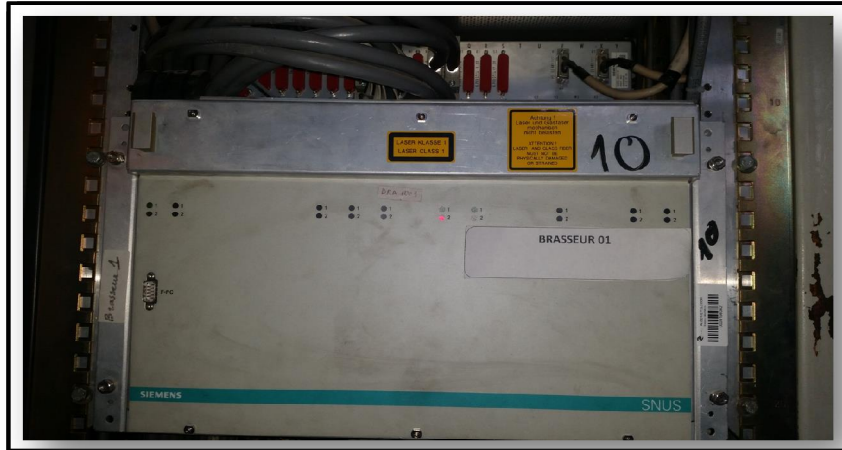
Figure II.9 : équipement d'un brasseur optique
