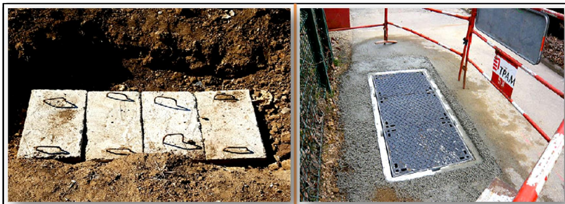
Figure III.7 : Tampons de protection de chambre
