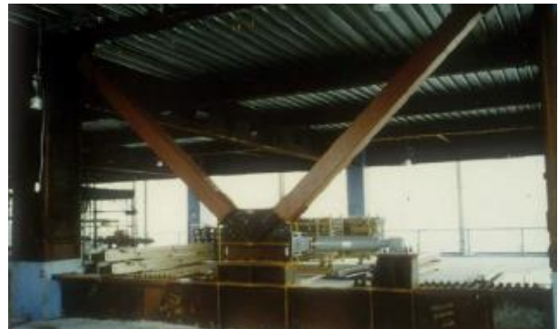
Figure 4.21 : Amortisseur de Sumitomo [98, 6]
