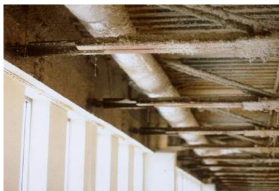
Figure 4.27 : Amortisseur viscoélastique solide (WTC, N.Y) [6, 35]
