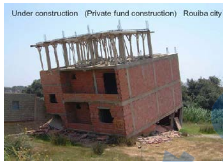
Figure 2.8 Exemple d'effondrement d'une maison lors du séisme de Boumerdès
