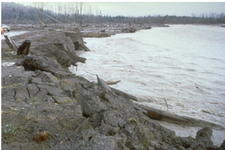
Figure 1.10 : Affouillement d'une digue.
