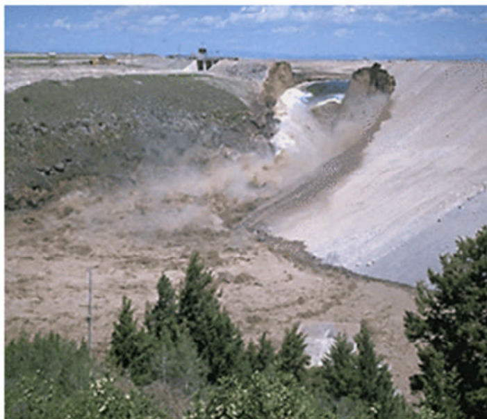
Figure 1.13 : Rupture du barrage Teton en 1976.
