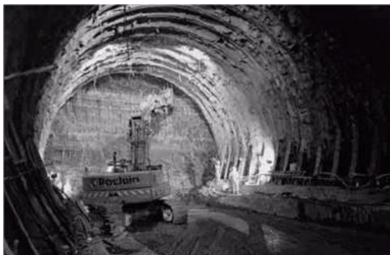
Figure. 1.7 : Creusement en pleine section. ( Djenane M, 2010 )
