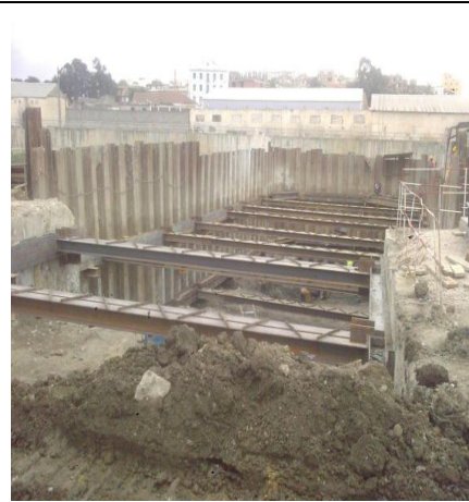
Figure IV.12: Étayage des palplanches (Omrani K et BOUTRIA H, 2012)
