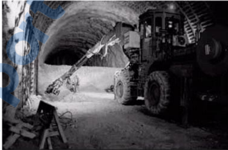
Figure. 1.6 : Creusement en demi-section. (Djenane M, 2010)
