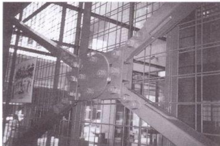
Figure 1.6 : Amortisseurs à frottement
