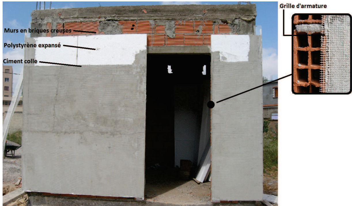
FIGURE 2.11: Photo des différents composants du mur
