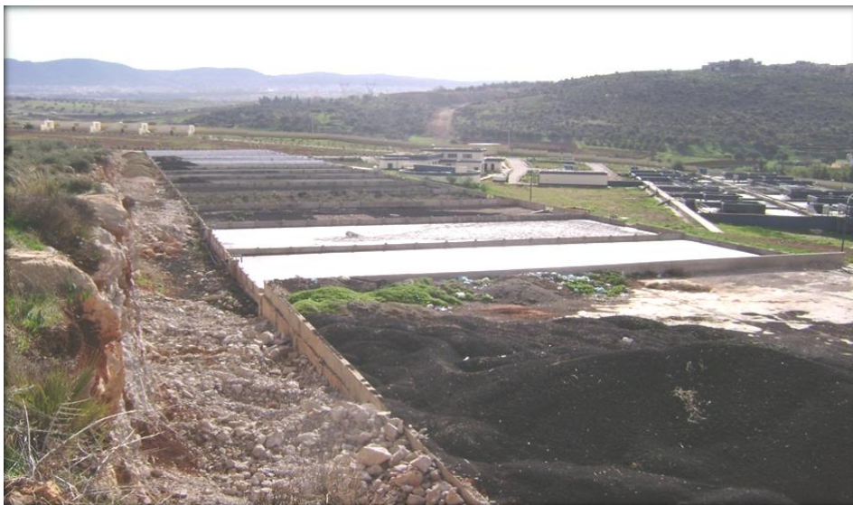
Figure III.14 : Photo de l'Aire de stockage des boues séchées
