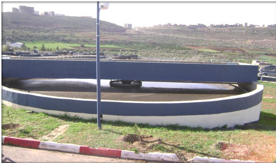
Figure III.12 : Photo d'un épaisseur des boues [36]
