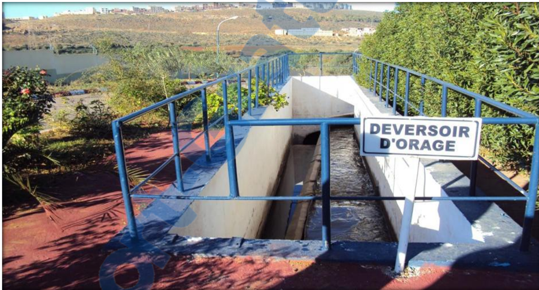
Figure III.3: Photo du déversoir d'orage
