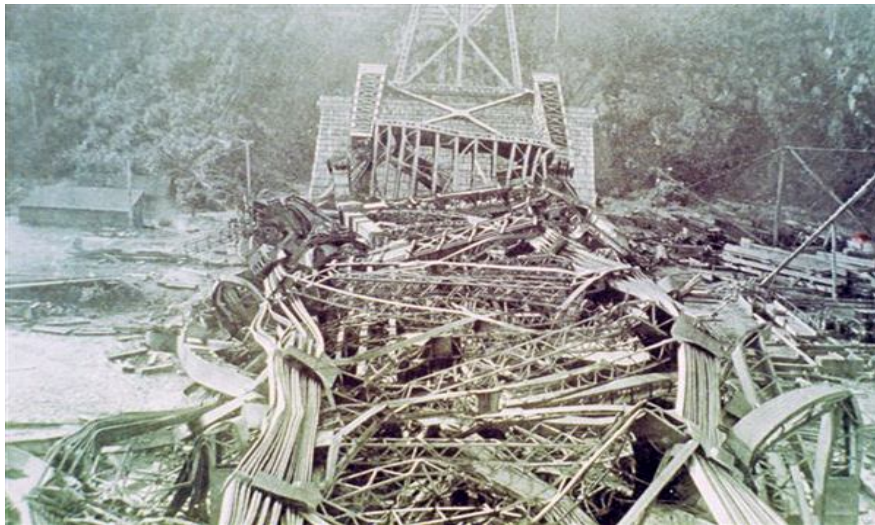
Photo I.1 : L'effondrement du pont de Québec 1907
