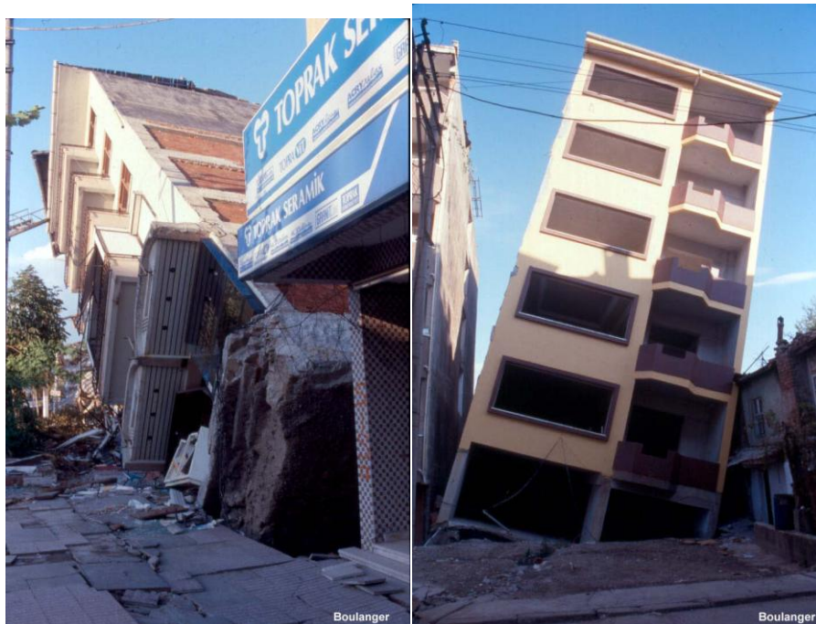
Figure 3. 5 : Dommage des édifices, Adapazani, Turki, 1999.
