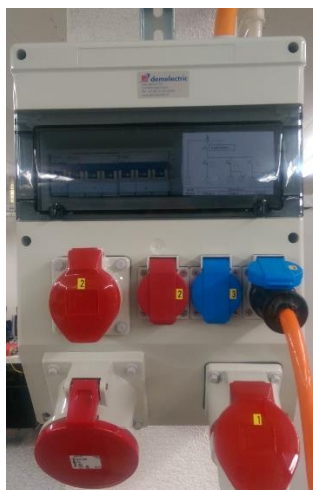
Figure 36: Tableau d'alimentation du PM15 et schéma du tableau (demelectric.ch)
