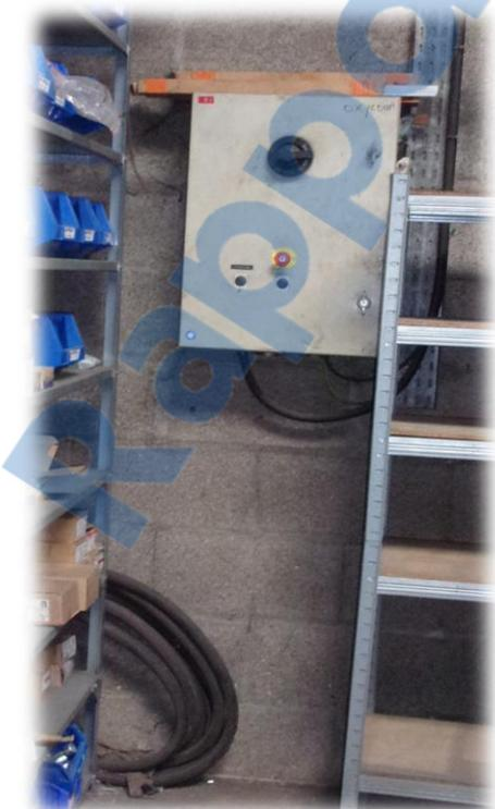
Pour conclure sur les analyses de photos de l'espace magasin, il faut impérativement que la boulonnerie soit séparée du reste du magasin car les employés ont besoin d'aller de temps en temps chercher de la visserie et surtout car nous avons une source d'énergie avec un arrêt d'urgence en cas de problème. Il doit être accessible par le plus de monde possible en cas d'urgence. C'est une question de sécurité.
