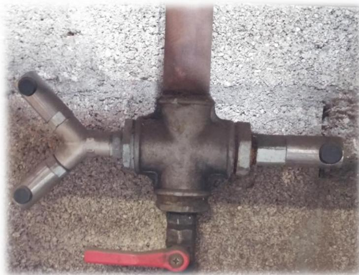
Lors de mes inspections et du temps passé dans le magasin j'ai remarqué des tuyaux sur le mur amenant de l'air. Nous pouvons nous servir de ces tuyaux pour brancher une soufflette, qui permettra d'enlever la poussière sur les étagères et de la ramener dans un coin pour que ce soit plus facile de l'enlever et surtout, ça perdra moins de temps, qui on sait dans une entreprise est très précieux.
