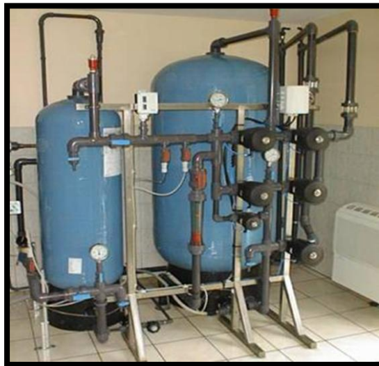
Figure N°12: Déferrisation et démanganisation physico-chimique [66].
