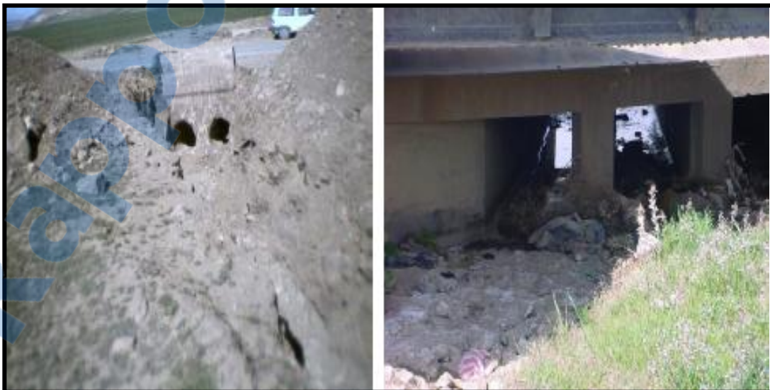
Figure 5.7 : Réalisation un ouvrage d'art (Halouche, 2007)
