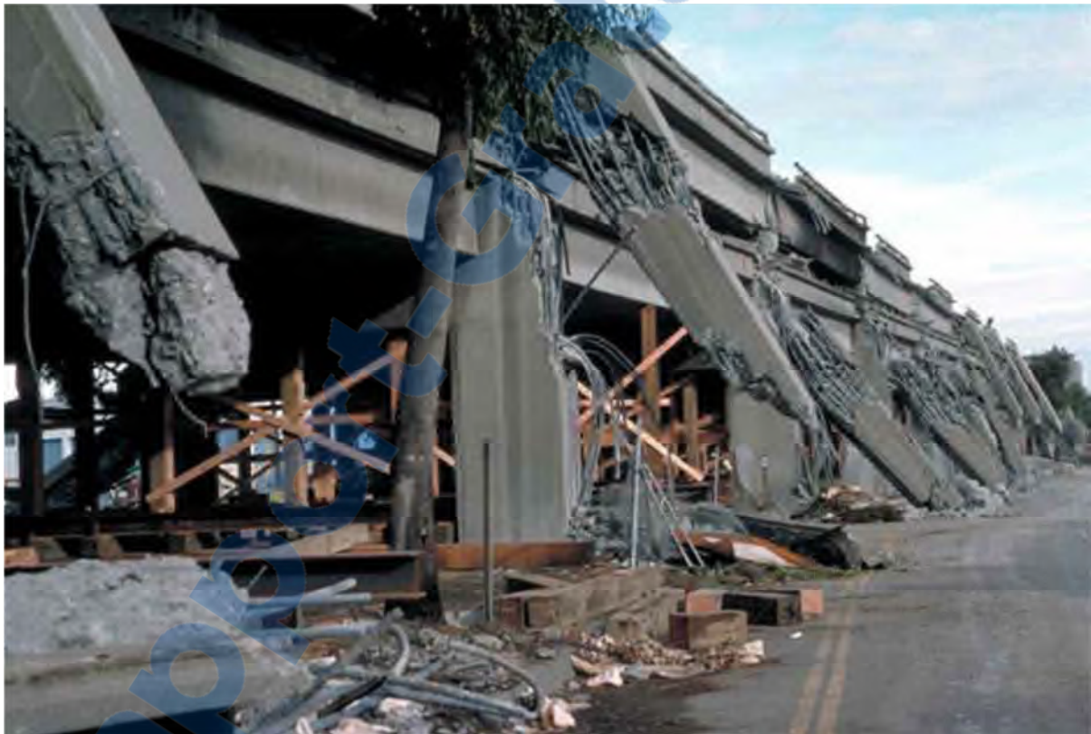
Figure I.2. Effondrement du premier niveau du viaduc de Cypress Street sur le pont inférieur suite au séisme de Loma Prieta en 1989[11]
