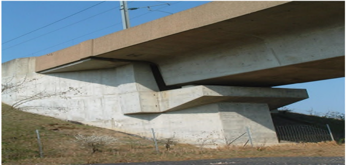
Figure I.5. Photo d'une culée d'un pont [8]
