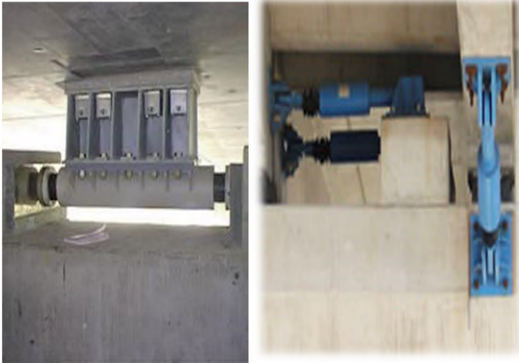
Figure II.9. Photo d'un amortisseur visqueux [12].
