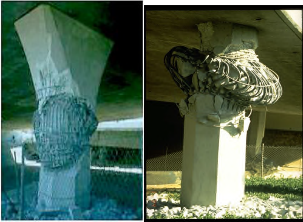
Figure I.4. Photo de la pile évasée du pont de la route 118 suite au séisme de Northridge en 1994[13]
