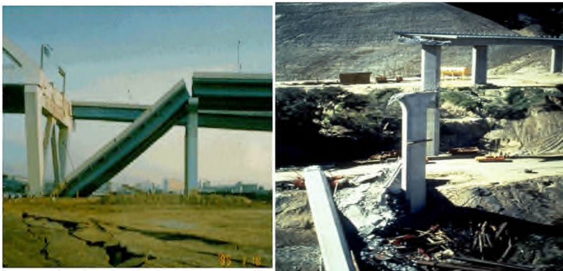
Figure I.1. Effondrement d'une travée du pont de Nishinomiya-ko en 1995 suite au séisme de Nanbu/ San Fernando (USA, 1971) [7]
