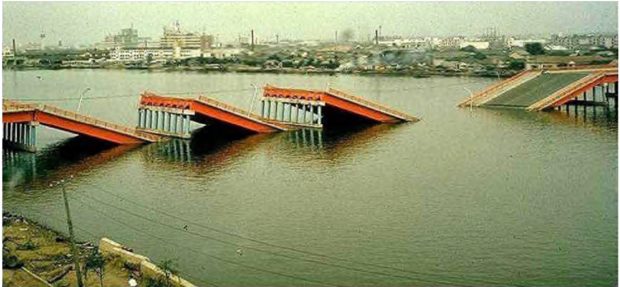
Figure I.3. Délogement des travées du pont de Showa suite au séisme Niigata [3]
