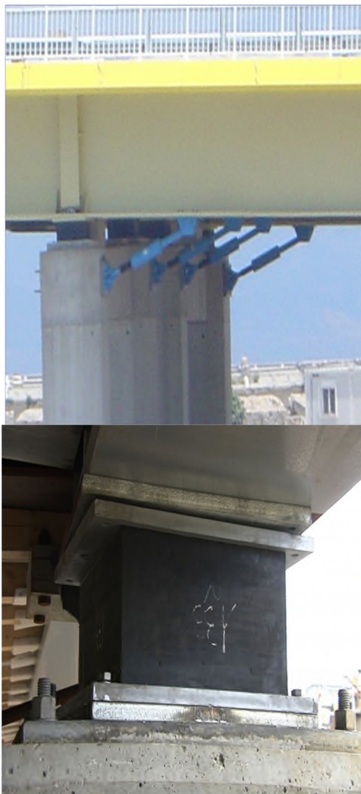
Figure I.11. Photo représente la localisation des isolateurs parasismiques pour les ponts [17].
