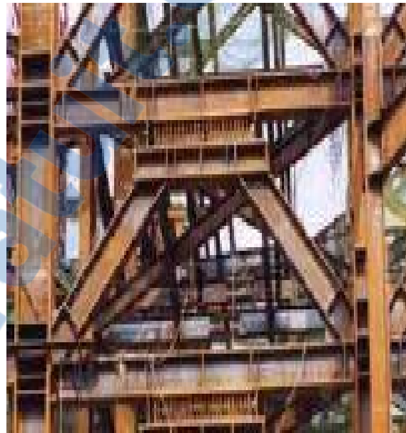
Figure II.3 : Amortisseur TADAS [8].
