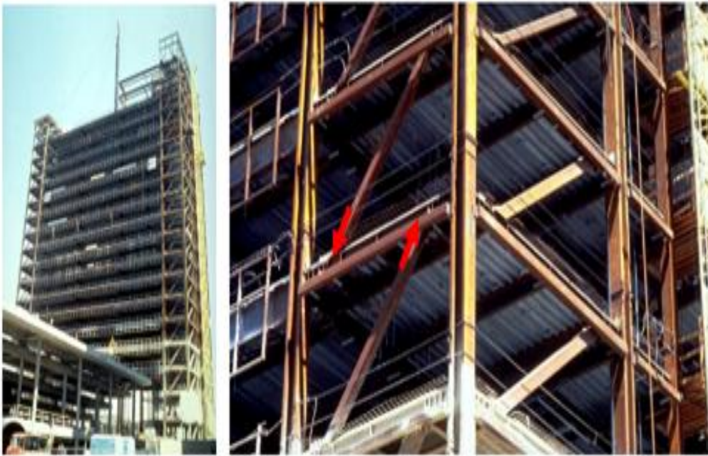
Figure I.13 : Contreventement excentré [3].
