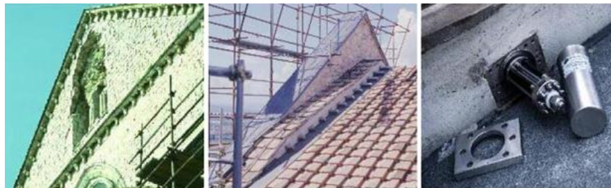
Figure 3.8 : Basilique Saint François à Assise en Italie, modernisation du tympan endommagé par l'introduction de trois groupes d'actionneurs en AMF (Pampanin, 2006).
