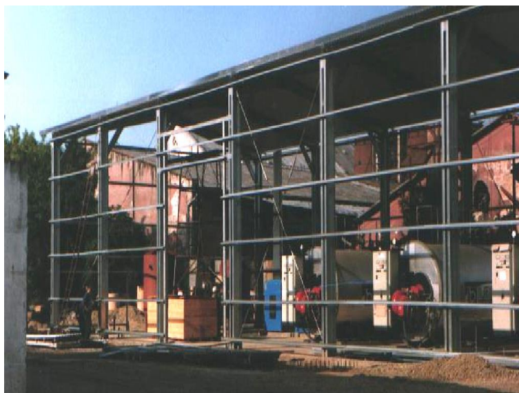
Figure 1.14. Sections en Z et en C utilisées comme pannes et lisses de bardages
