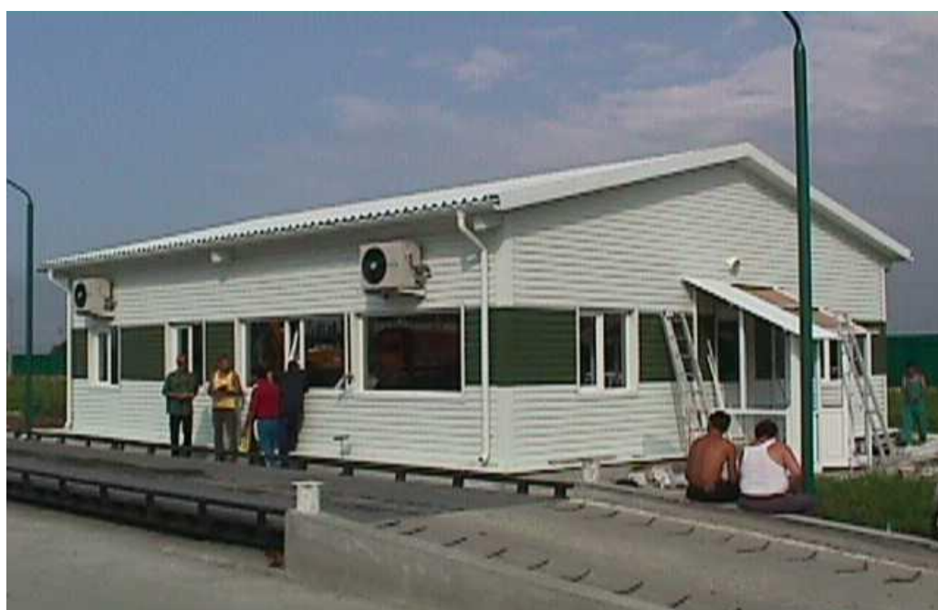
Figure 1.24. Système modulaire mur à ossature (WSMS) pour des tailles petites et moyennes de la construction, installations à l'aide de poutres pour la structure du toit et de la résistance contre les actions horizontales: a) la structure d'encadrement; b) bâtiment achevé (Dubina et al, 2001a)
