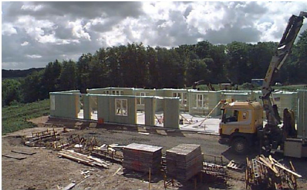
Figure 1.18. Installation des éléments préfabriqués
