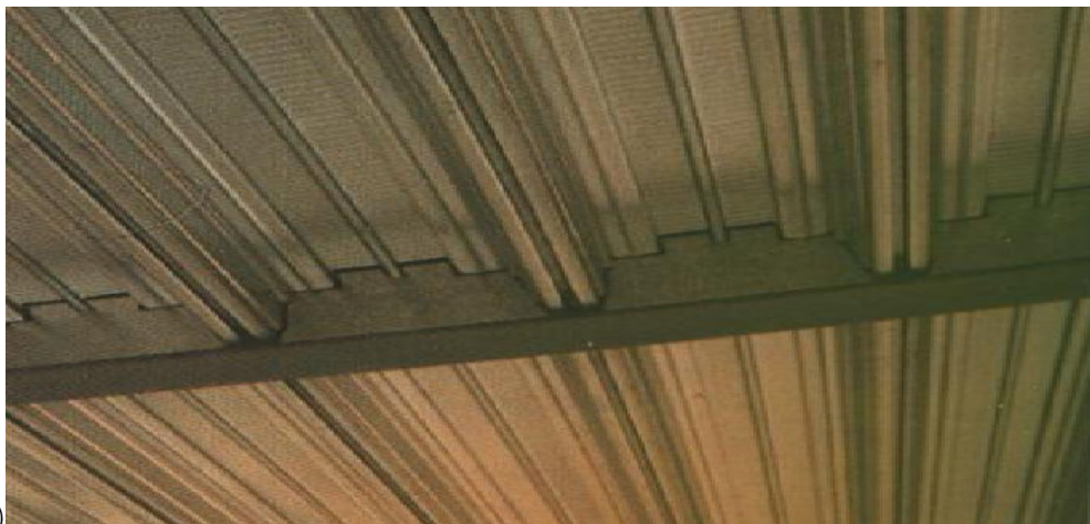
Figure 1.21. Plancher mixte acier-béton a) Planchers mixte acier béton avec des tôles et poutres en acier b) Revêtement de structure et des armatures d'une structure mixte acier-béton c) Positionnement des tôles sur des poutres d'acier.
