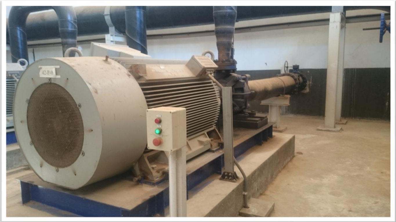
Figure II.20 : Pompe centrifuge de la Station de pompage de Souk-Tleta
