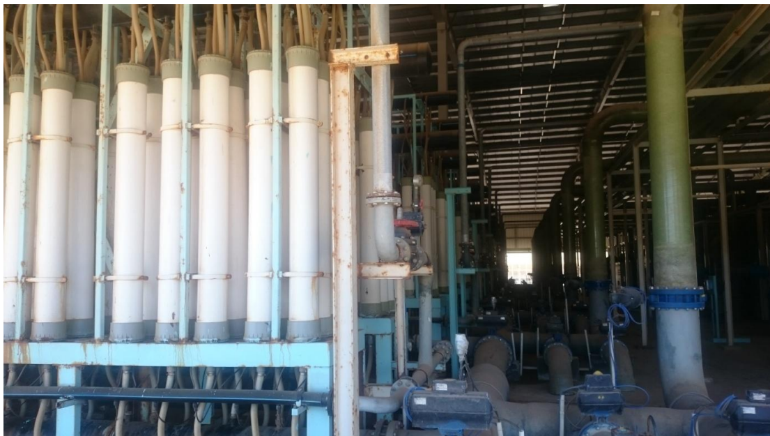
Figure I .12 : Salle d'ultrafiltration (les trains)
