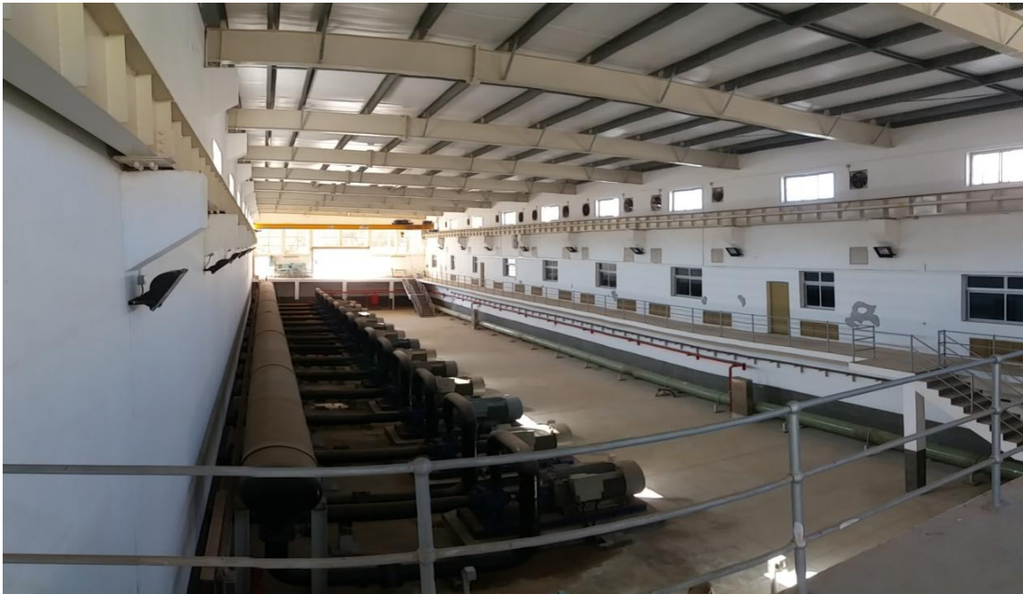
Figure I .17 : Salle de pompage eau potable vers l'ADE
